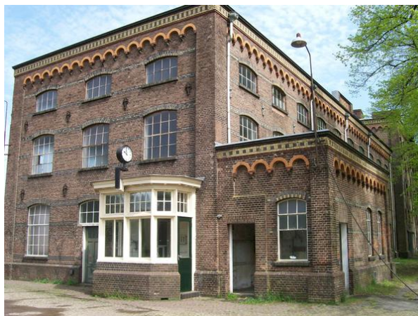
Gebouw, gered van de slopershamer
